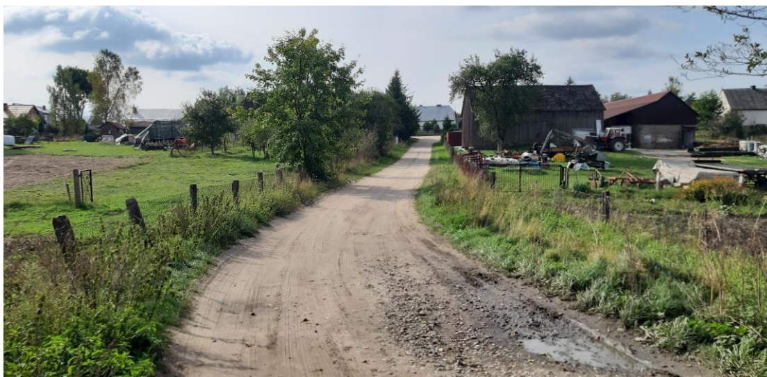
Fot. 7 – Fragment drogi gruntowej w sołectwie Gotelp
