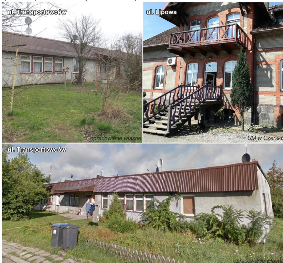
Ryc. 38. Budynki mieszkalne w złym stanie technicznym
