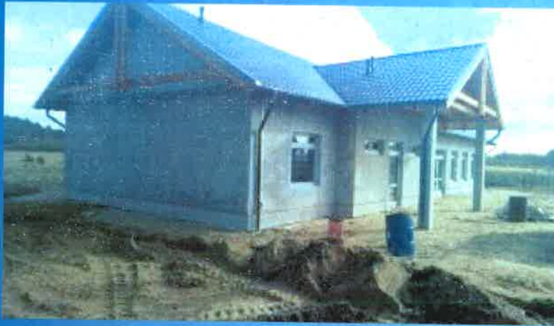
Budowa świetlicy w Klaskawie
