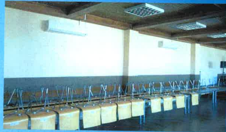
Montaż klimatyzacji w świetlicy w Gotelciu
