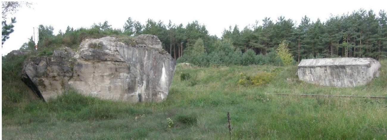
Fot. 15. Zniszczony (wysadzony) ok. 1980 r. wiadukt kolejowy na drodze w kierunku Kłodni
