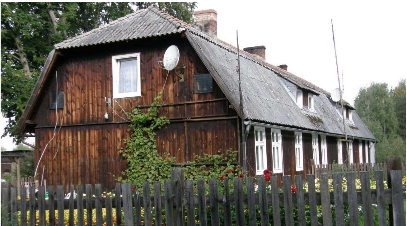
Fot. 8. Dawny budynek biurowy nieistniejącego już dzisiaj tartaku – obecnie mieszkania.
