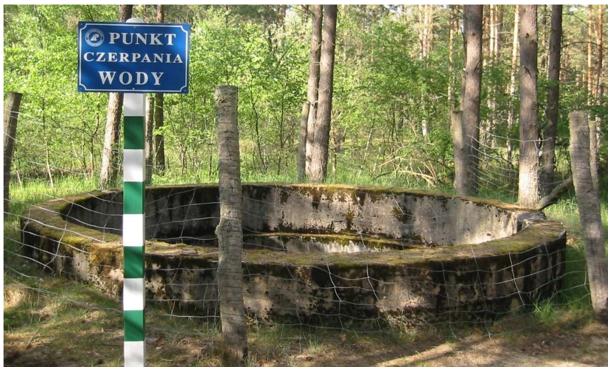
Fot. 13. Jeden z betonowych zbiorników śródleśnych na wodę.
