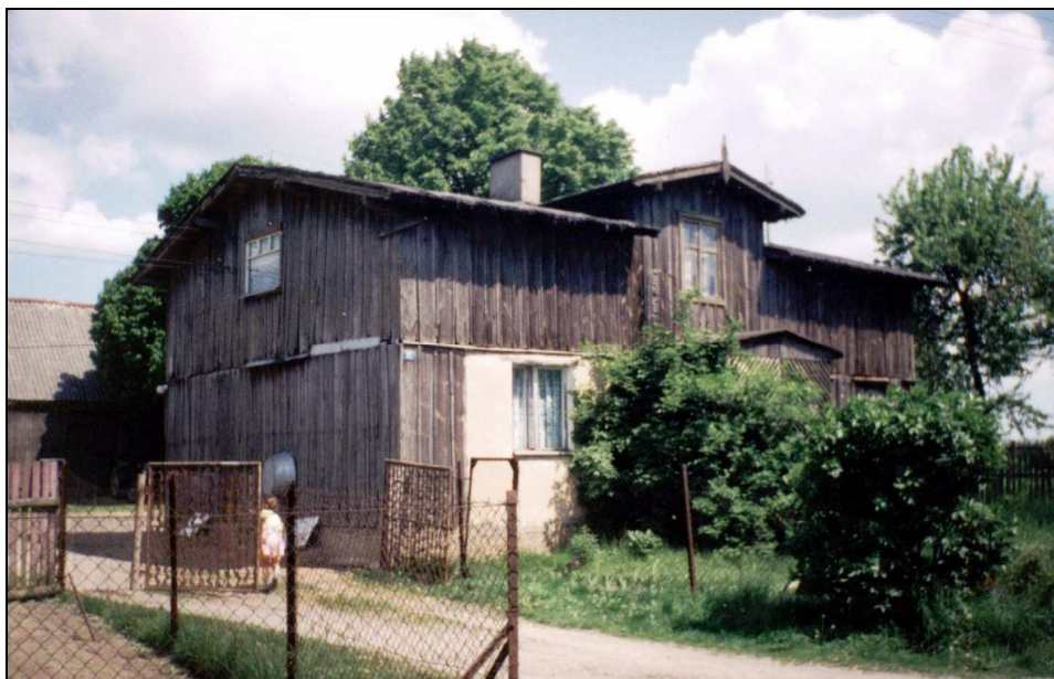
Drewniany budynek z końca XIX w.
