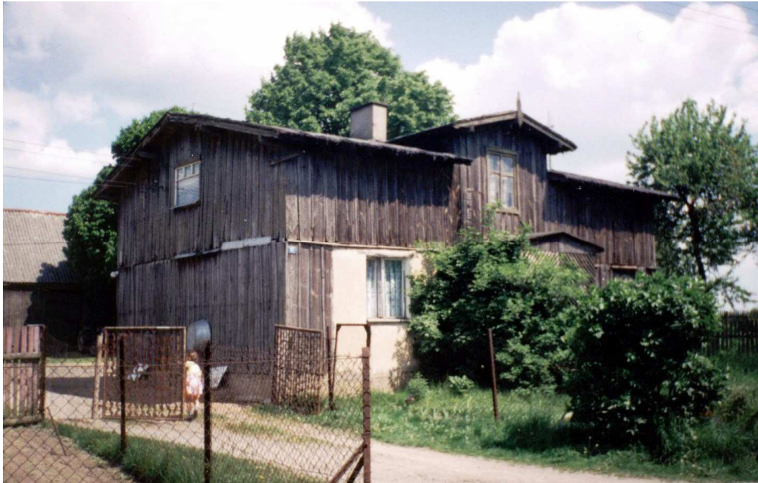
Drewniany budynek z końca XIX w.
