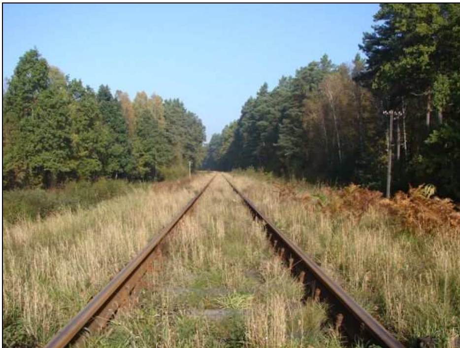
Fot.7 - linia kolejowa nr 215 Laskowice – Czersk – Bąk, przebiegająca na wschód od wsi
