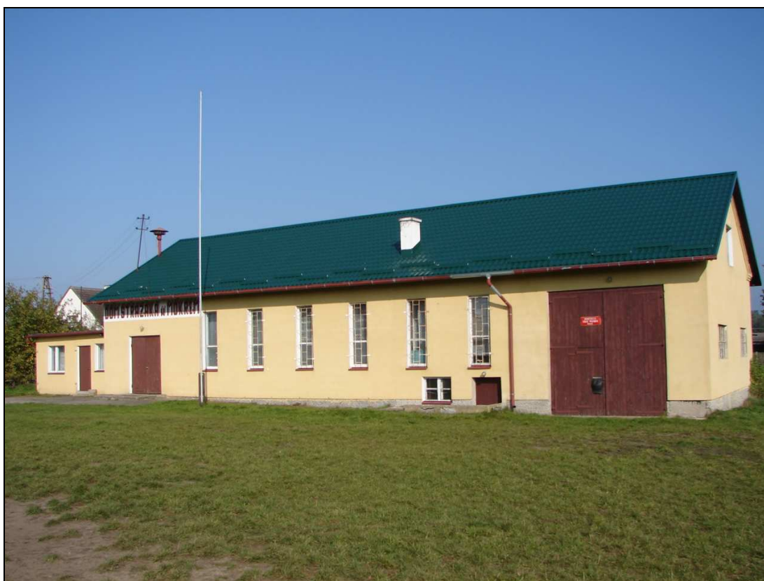
Fot.25- Budynek remizy OSP w Mokrem
