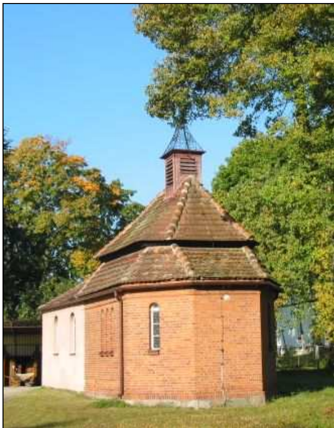
Fot.11 – kaplica św. Józefa (bryła budynku)
