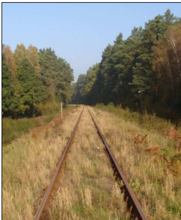
Fot.5 Linia kolejowa Laskowice – Bąk
