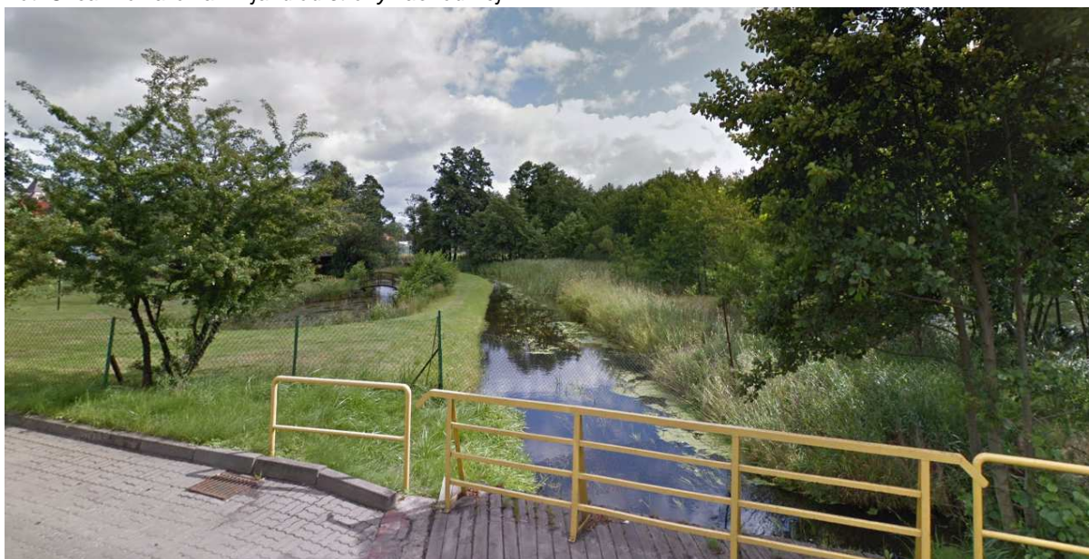
Fot. 6. Czerska Struga – widok z Alei 1000-lecia
