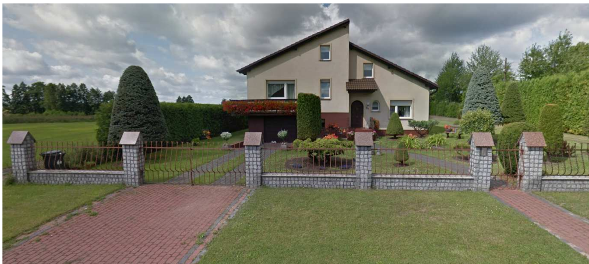
Fot. 10. Dom jednorodzinny przy Alei 1000-lecia 6A
