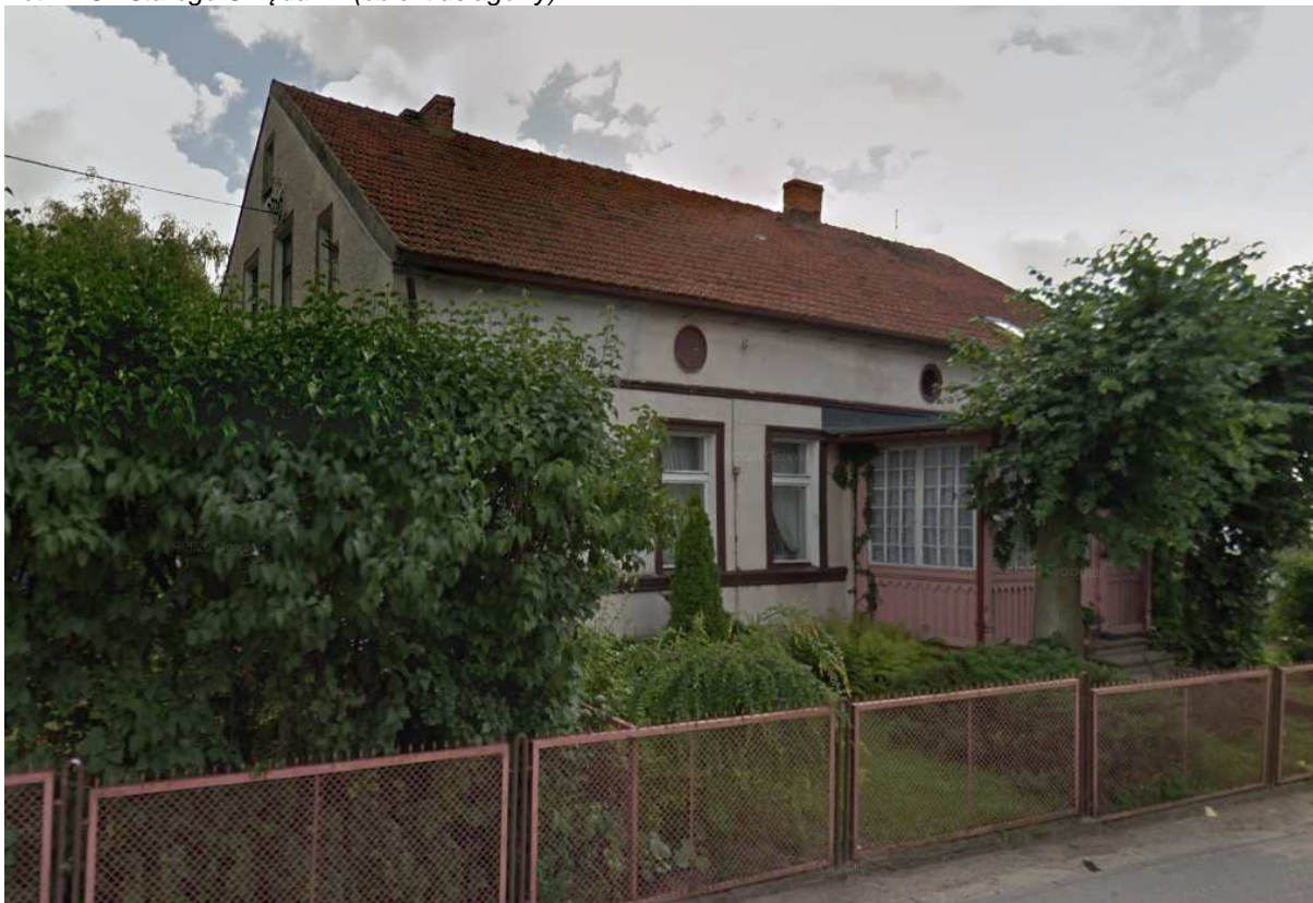
Fot. 3. Ul. Starego Urzędu 20, dom mieszkalny
