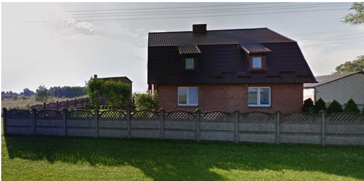
Fot. 36. Dom mieszkalny Łąg-Kolonia 6
