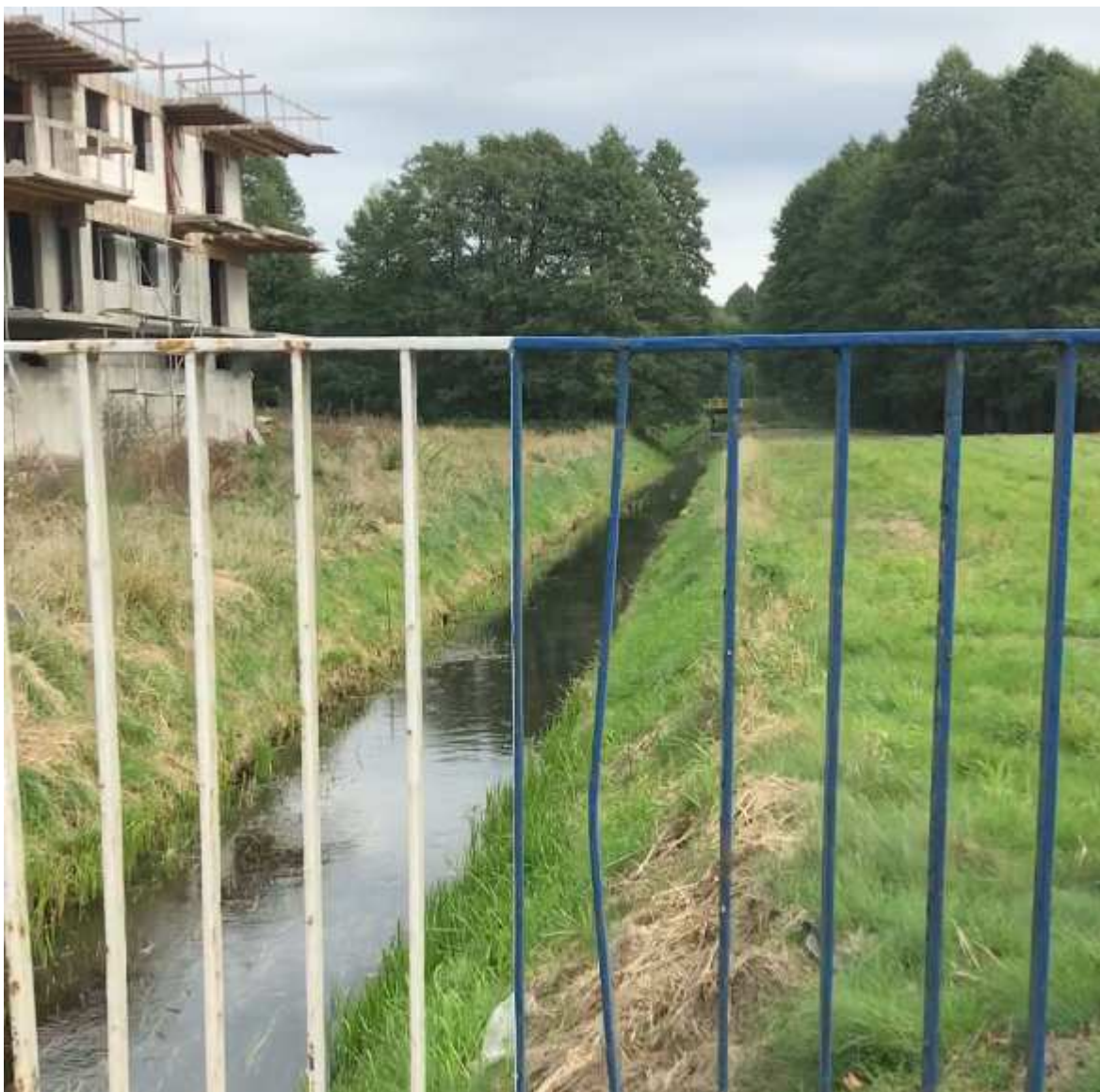
Fot. 5a. Budynek wielorodzinny w budowie przy ul. Starego Urzędu nad Czerską Strugą
