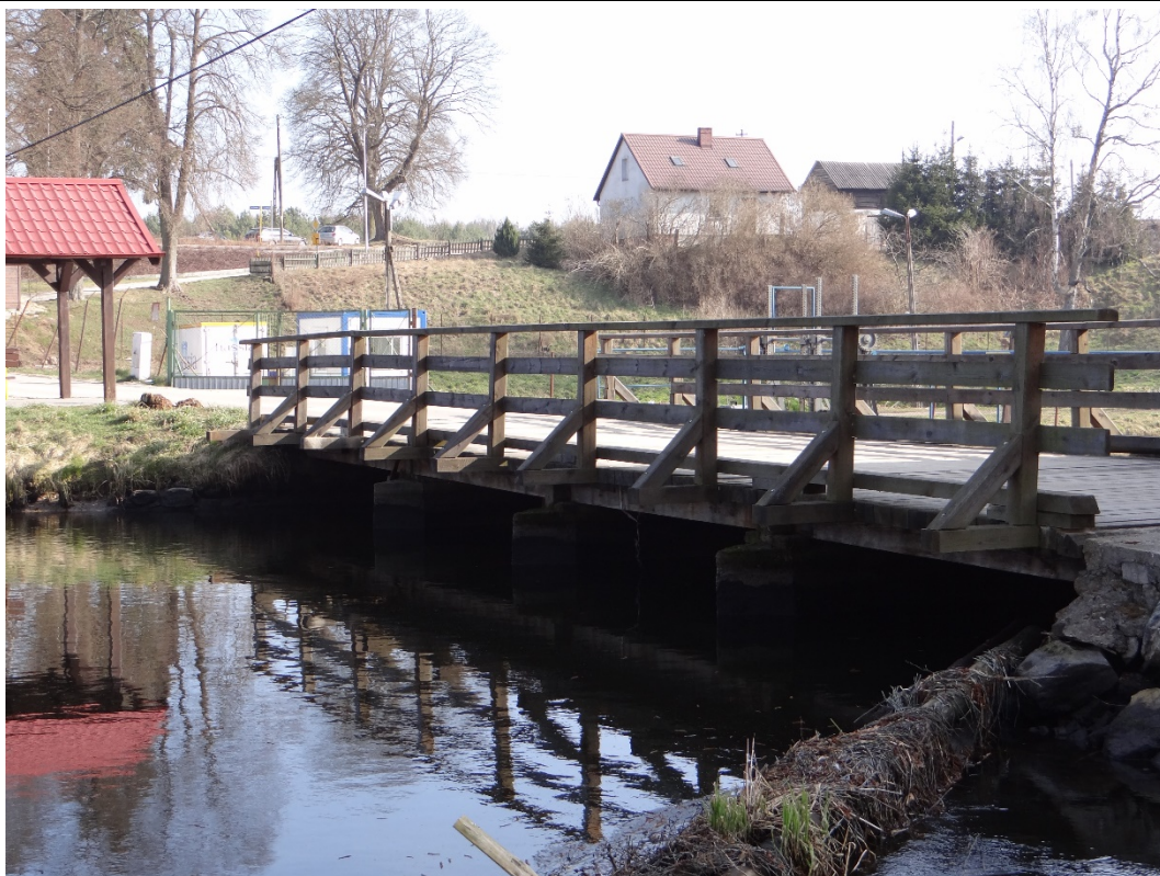
Rysunek 1. Widok od strony górnej wody.
