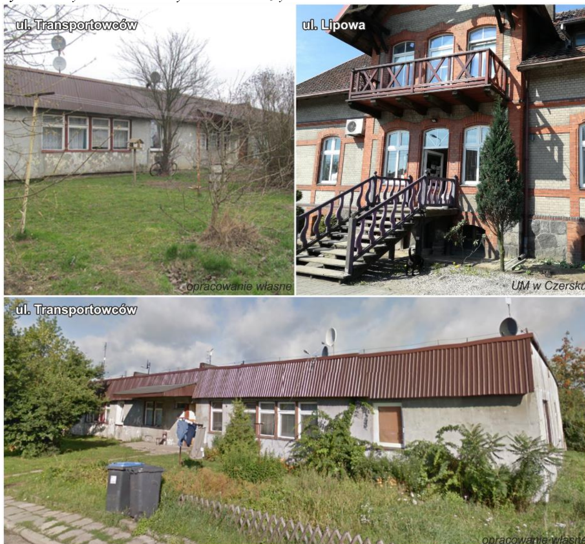
Ryc. 38. Budynki mieszkalne w złym stanie technicznym
