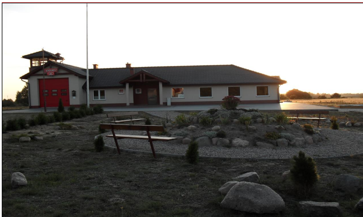
Fot. Budynek Lokalnego Centrum Kultury, Edukacji i Organizacji Pozarządowych wraz z Remizą OSP Będźmierowice
