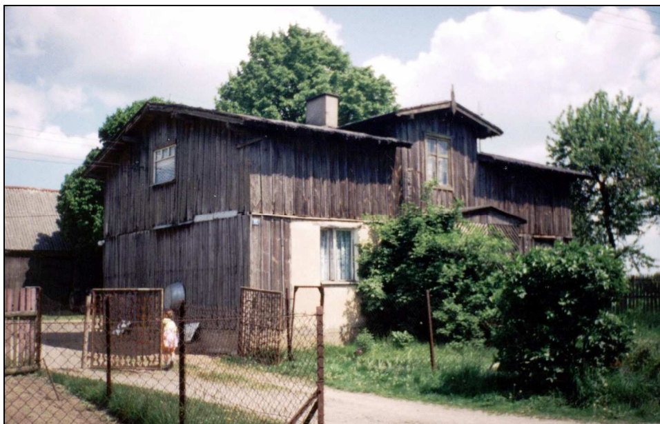
Drewniany budynek z końca XIX w.
