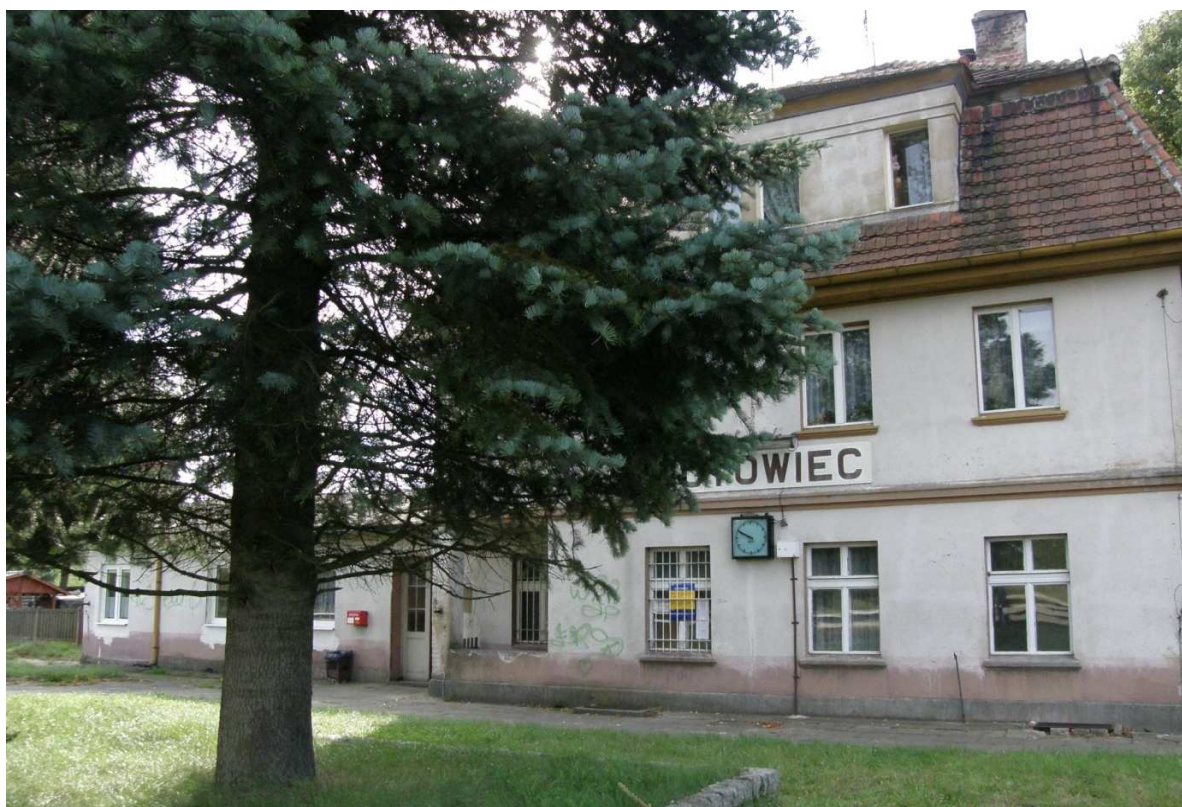
Fot. 16. Budynek dworca PKP
