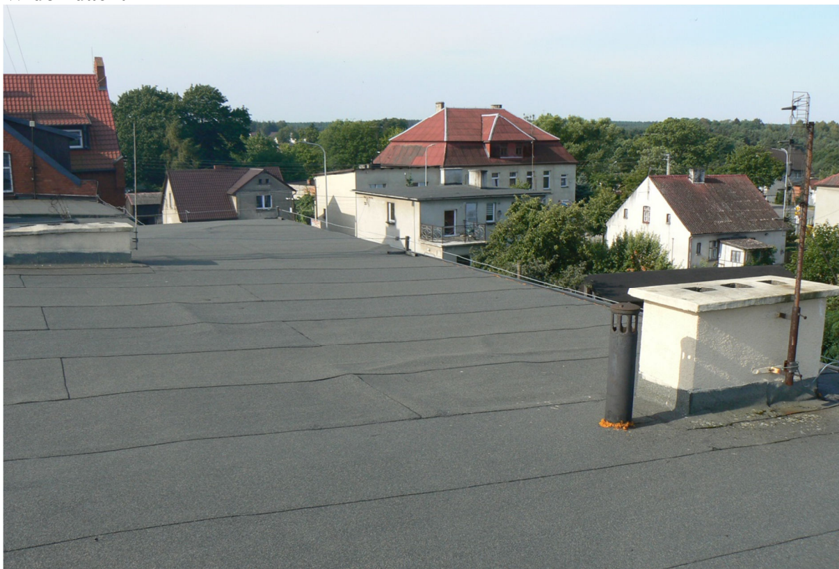
Widok uszkodzeń obróbek blacharskich i papy
