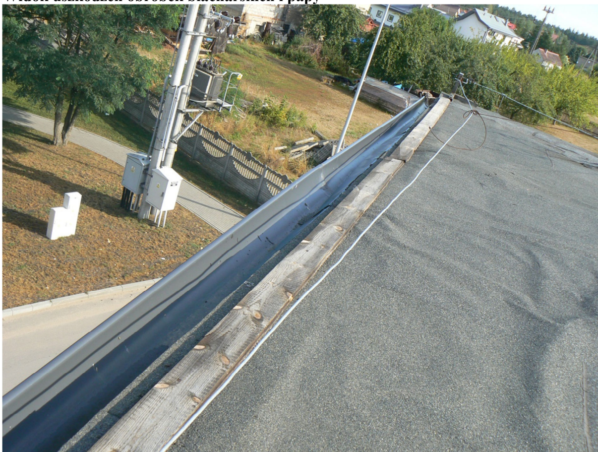
Widok uszkodzeń obróbek blacharskich i papy
