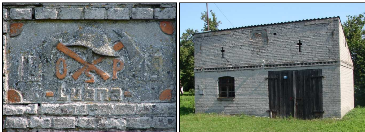
Fot.19/20 – sygnaturka oraz budynek powojennej remizy OSP w Łubnej
