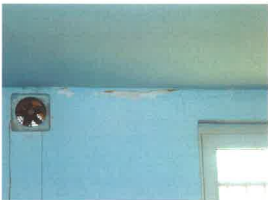
Fragment ścian kuchni w świetlicy
